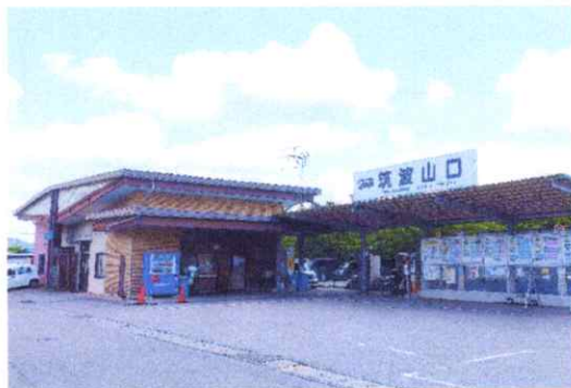
旧筑波駅を利用した関鉄つくば北営業所
